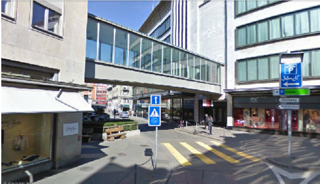
Jelmoli-Passerelle, Seidengasse 1, 8001 Zürich
